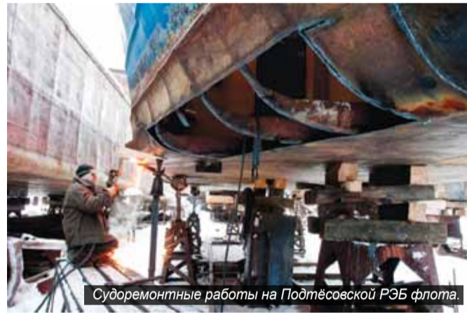
На ремонте – теплоход «ОТА-968», Красноярский судоремонтный центр.
