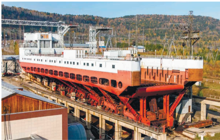
Красноярский судоподъёмник – сооружение уникальное.
